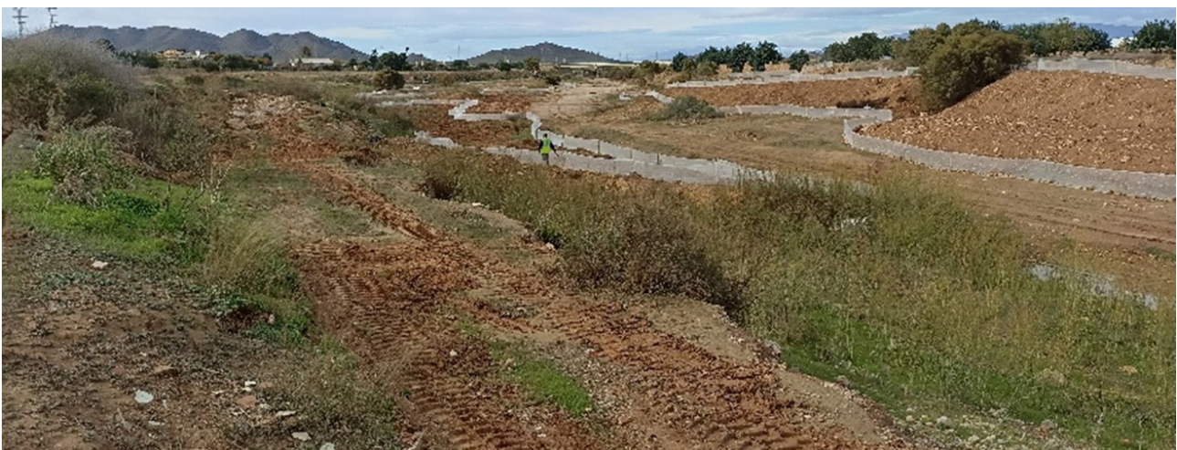
Actuaciones de limpieza y renaturalización en los cauces de la rambla del Albuñón
