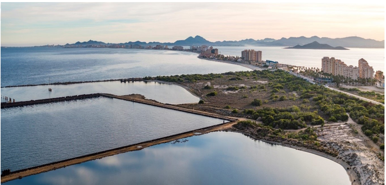
Imagen área de la zona de actuación sobre Puerto Mayor (La Manga).
